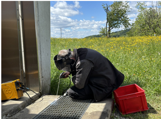
Bild 6 Res schweisst das gebrochene Scharnier am Schuhrost
